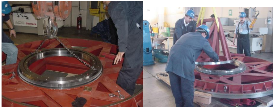
Figura 12.3: Colocación de rodamiento sobre estructura principal (izq) y colocación de estructura de soporte (der)
