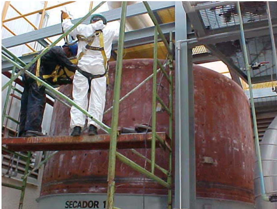
Fig. 2 Inspección de tanque de almacenamiento por ultrasonido.
