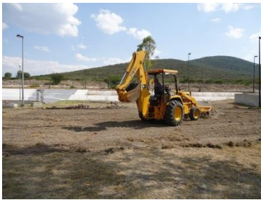
Preparación de terreno
