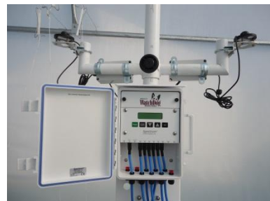
Instalación del sistema Estación-Sensor
