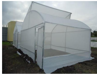
Instalación de módulos
