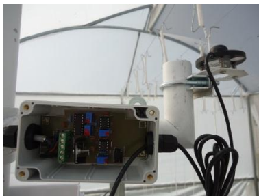
Instalación del sensor radiométrico
