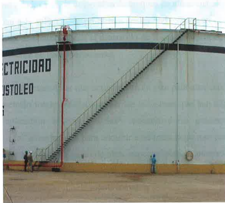
Figura 2 Tanque de almacenamiento para combustoleo
