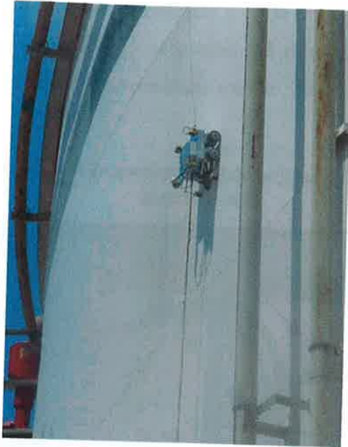
Figura 5.14 Medición de espesores de tanques de almacenamiento.
