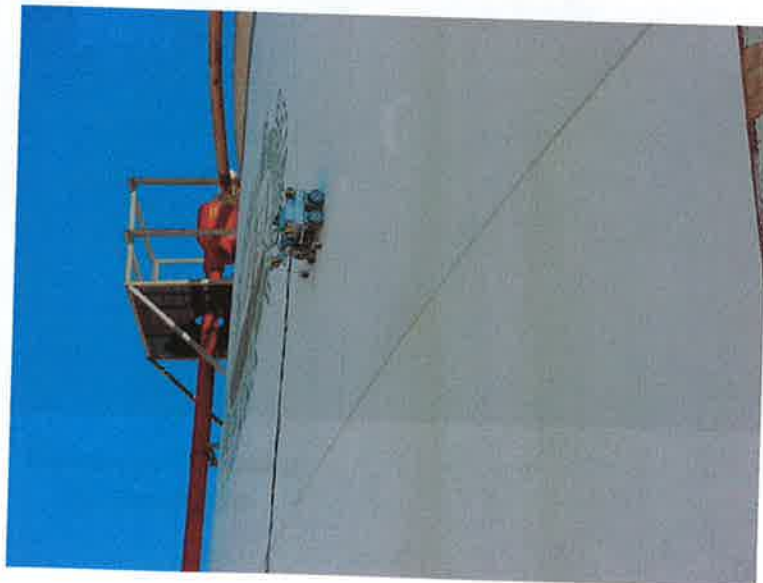
Figura 5.15 Medición de espesores de tanques de almacenamiento.
