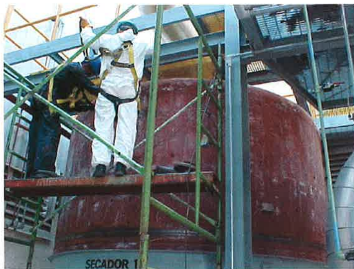
Figura 1.2 Inspección de tanque de almacenamiento por ultrasonido.
