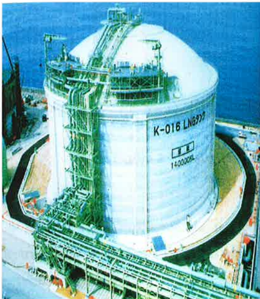
Figura 1 Tanque de almacenamiento
