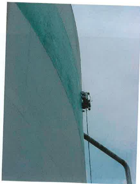
Figura 5.13 Medición de espesores de tanques de almacenamiento.
