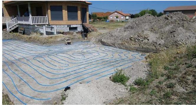
**Figura 2.7. ICGH instalado en el subsuelo.**
