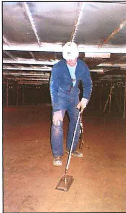
Fig.17.- Inspección por fuga de campo magnético
