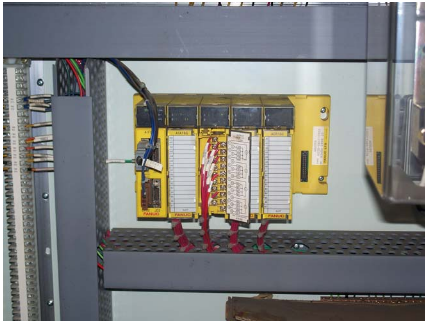
Figura 6.6-1. Módulos de E/S de los robots FANUC
