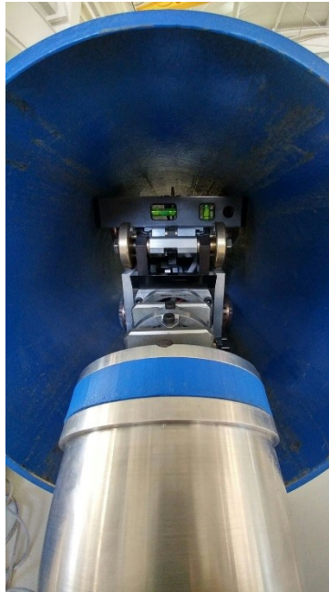
Figura 40. Pruebas preliminares de tracción interna tubo completo observando su inclinación y su velocidad de avance
