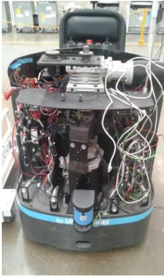
Figura 25. Implementación y cableado del circuito eléctrico.
