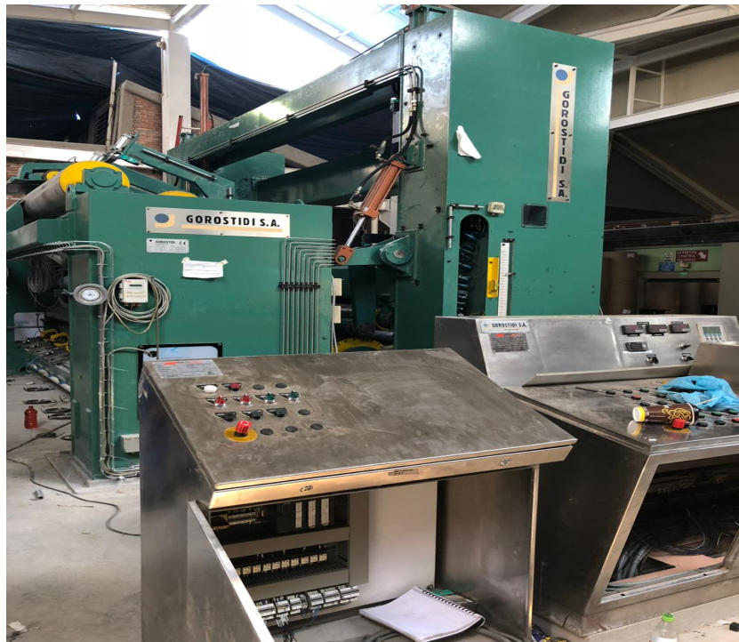
FIGURA 7.4: Tableros de control.
