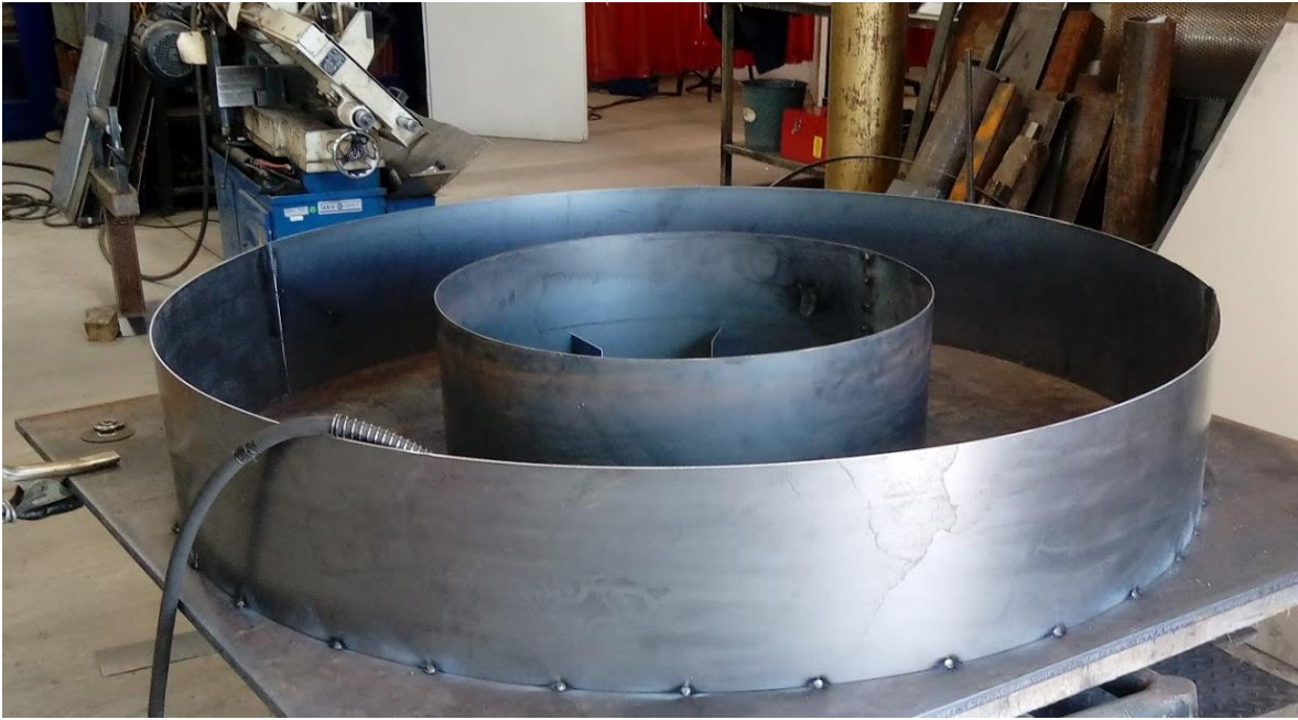
Figura. 41 Muestra el molde en Acero al Carbón para la fabricación del flotador para la Boya de Monitoreo.
