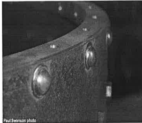
Figura 1.1.6. Aplicación de riveteado de gran resistencia para el caso de un recipiente contenedor.
