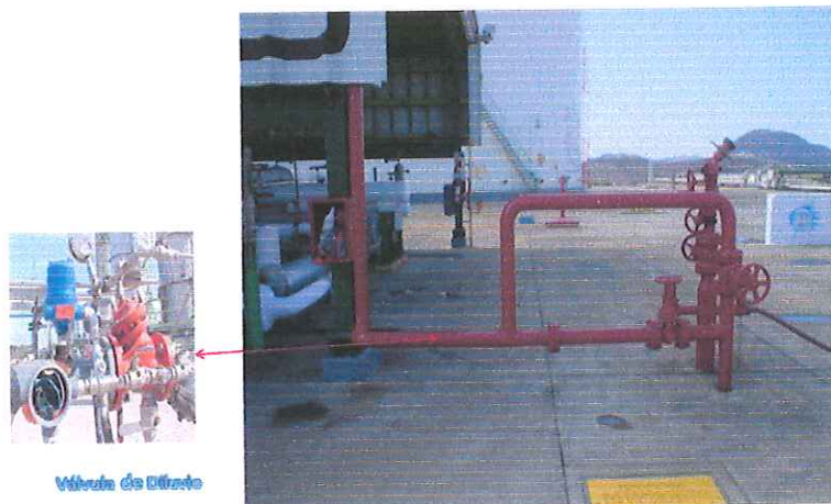
Figura 7.12. Ubicación de Válvula de diluvio.
